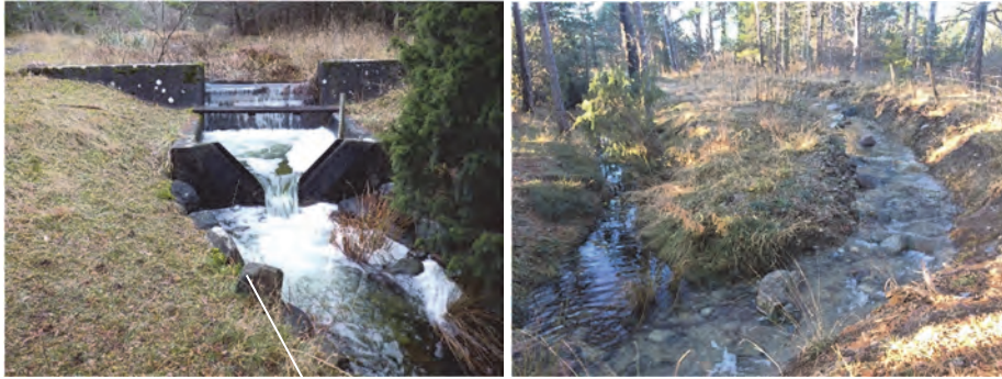
Figur 29. Dammen och det definitiva vandringshindret vid utloppet ur Hau träsk, samt nedre delen av omlöpet i Hauån. Foto: Lars Vallin.
