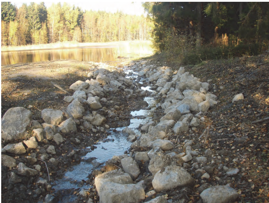
Figur 27. Omlöpet norr om dammvallen som möjliggör fiskvandring till översvämningsytan. Foto: Johan Andreasson. (notera att bilden är tagen strax efter anläggande, därför är det mycket lågt flöde)
