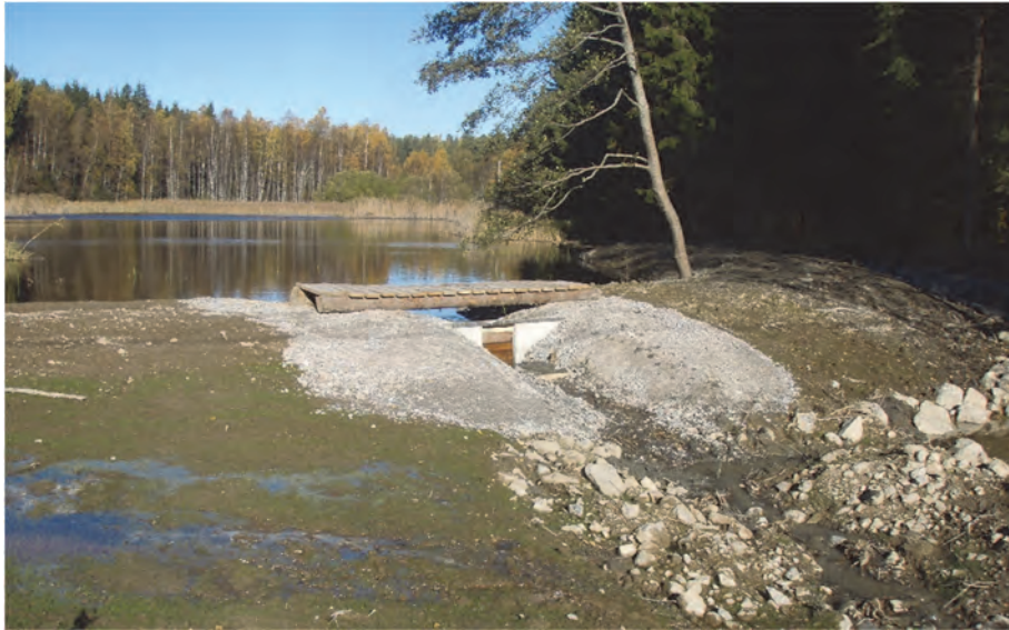
Figur 26. Tjuvkistan efter åtgärd. Omlöpet skymtas till höger i bild och regleringsdammen med sätare av trä ses mitt i bild. Foto: Johan Andreasson.
