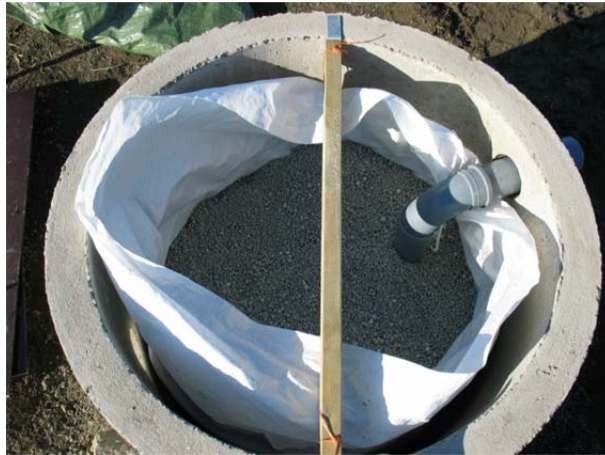
Figur 9: Brunn med filterkassett.
